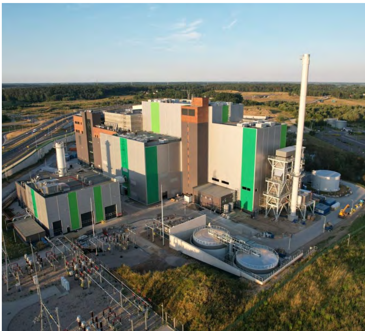
Instalacja Termicznego Przekształcania Odpadów przy ul. M. Bublewicza 6 w Olsztynie
