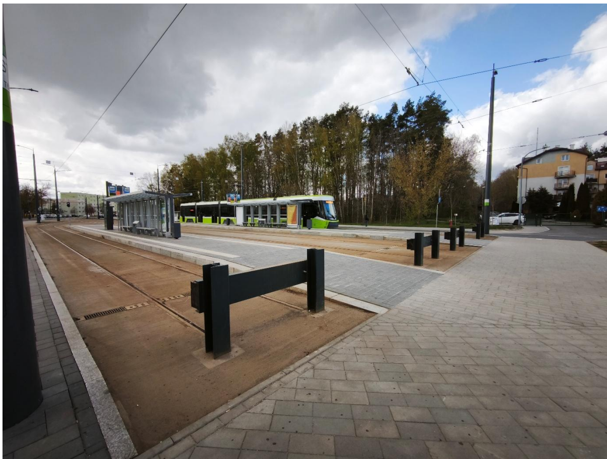
Rys. 1. Nowa pętla tramwajowa na osiedlu „Pieczewo”. Źródło: EkoKoncept s.c.
