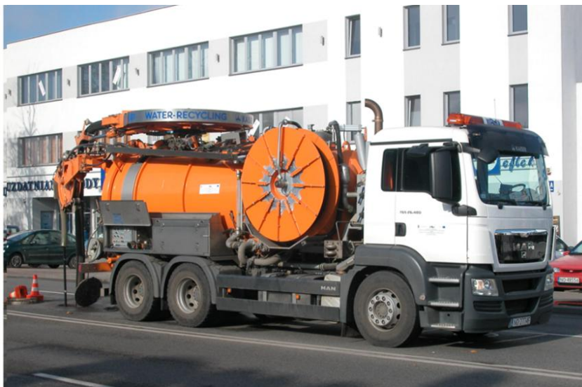
Rys. 8. Czyszczenie hydrodynamiczne sieci sanitarnej w ul. Lubelskiej. Źródło: PWiK Olsztyn
