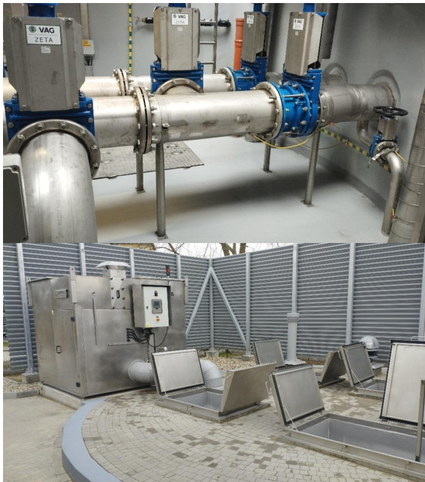
Rys. 7. Odtworzenie przepompowni ścieków P-4 przy ul. Bałtyckiej.
