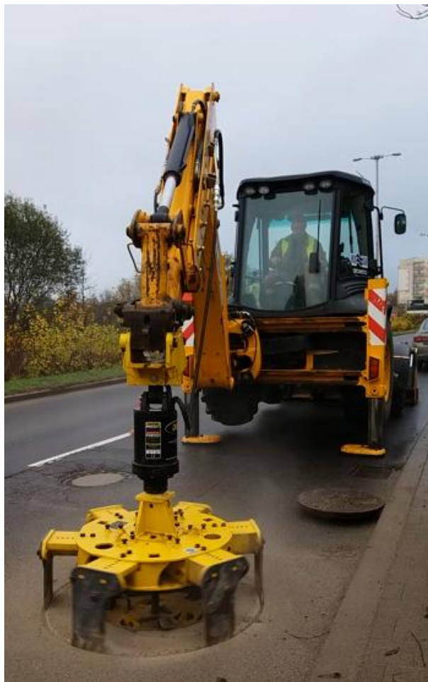
Rys. 10. Regulacja włączów na sieci sanitarnej za pomocą frezu hydraulicznego w ul. Synów Pułku.
