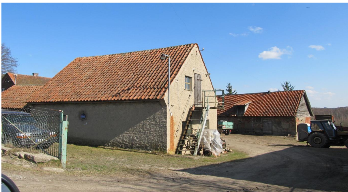
Zdjęcie 1. Istniejąca zabudowa w części północnej przy ul. Porannej
