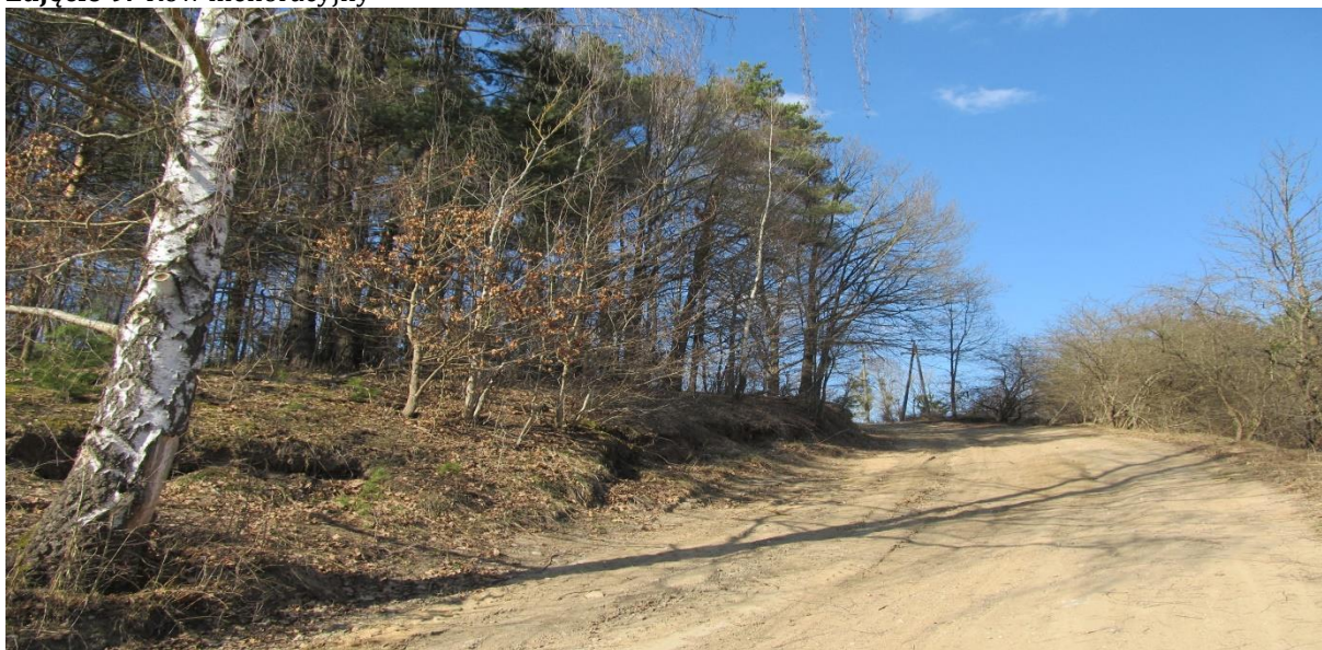
Zdjęcie 10. Stroma skarpa w zachodniej części obszaru, przy ul. Żurawiej
