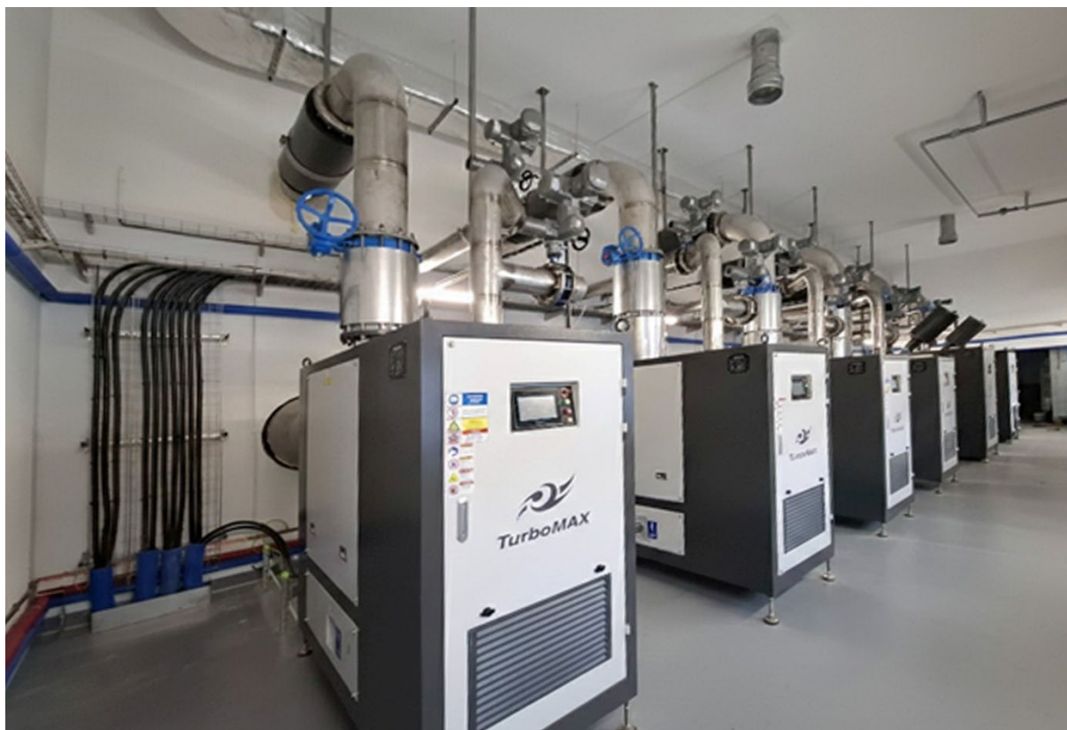
Fot. Modernizacja systemu napowietrzania ścieków w reaktorach biologicznych na terenie Miejskiej Oczyszczalni Ścieków „Łyna” w Olsztynie - montaż dmuchaw sprężonego powietrza na hali dmuchaw (źródło: PWiK Sp. z o.o.)
