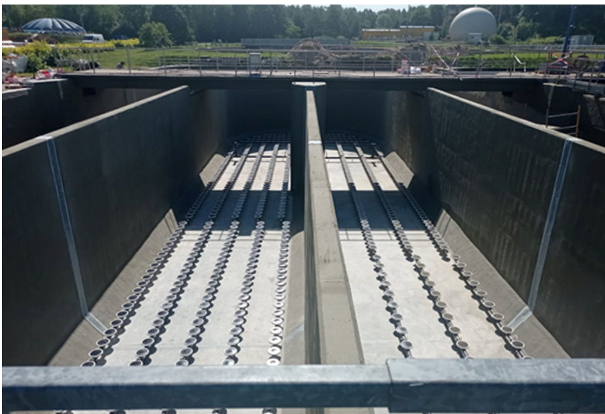
Fot. Modernizacja systemu napowietrzania ścieków w reaktorach biologicznych na terenie Miejskiej Oczyszczalni Ścieków „Łyna” w Olsztynie – montaż rusztów i dyfuzorów napowietrzających w bioreaktorze 18.1 (źródło: PWiK Sp. z o.o.)
