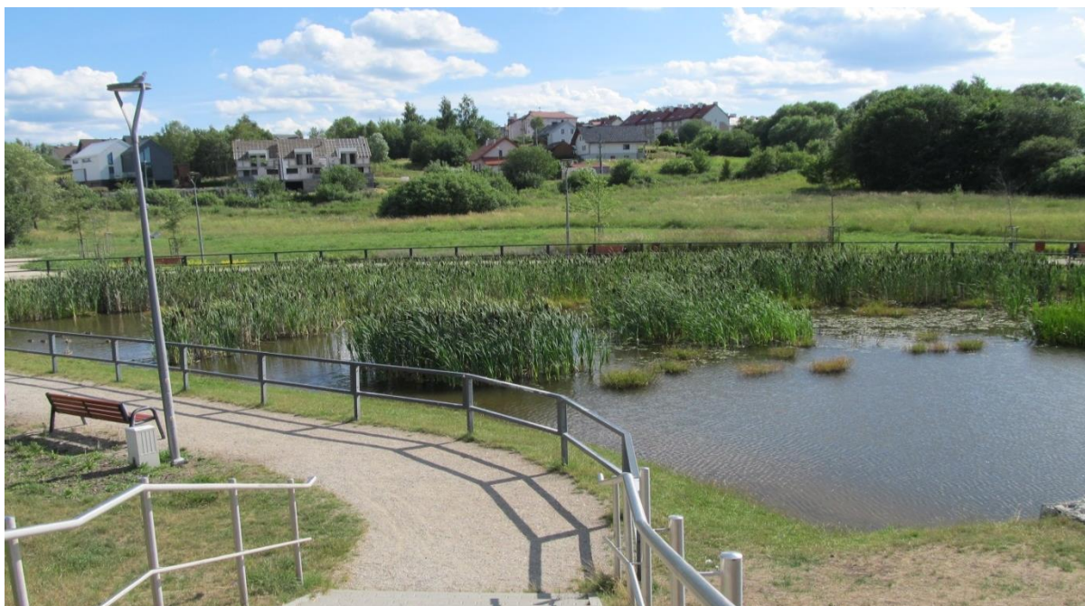
Zdjęcie 5. Zbiornik retencyjny wraz z roślinnością szuwarową na osiedlu Generałów
