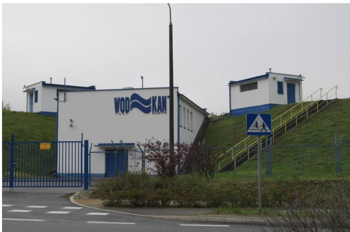
Zdjęcie 3. Teren ujęcia wody „Jaroty” wraz z SUW
