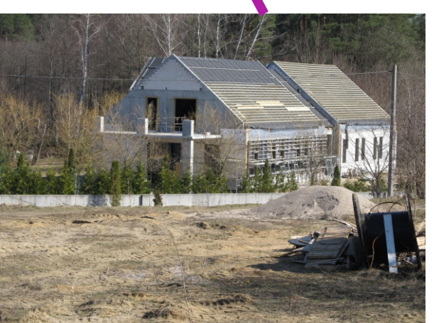
Nowopowstająca zabudowa - faza budowy
