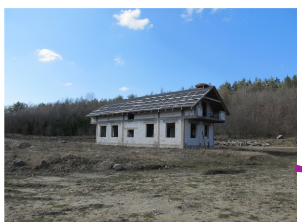
Nowopowstająca zabudowa - faza budowy
