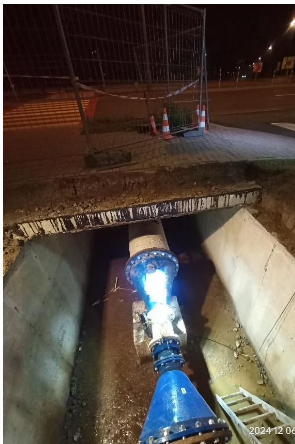
Fot. PWiK Sp. z o.o. Remont komory wodociągowej w ul. Sielskiej przy al. Schumana
