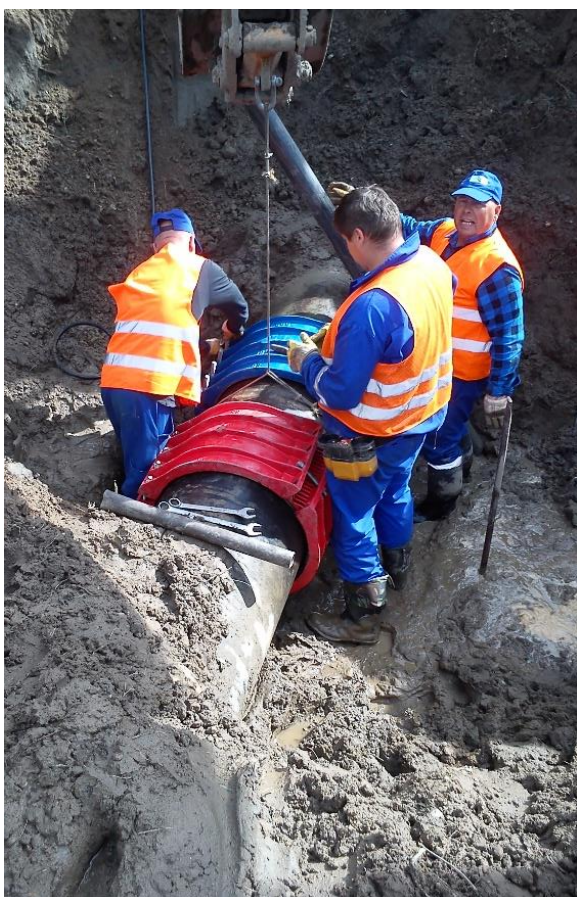
Fot. PWiK Sp. z o.o. Usuwanie awarii magistrali wodociągowej
