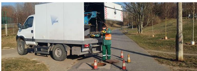
Fot. PWiK Sp. z o.o. Czyszczenie hydrodynamiczne sieci sanitarnej w ul. Lubelskiej
