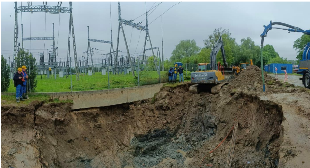
Fot. PWiK Sp. z o.o. Usuwanie awarii magistrali wodociągowej przy ul. Lubelskiej
