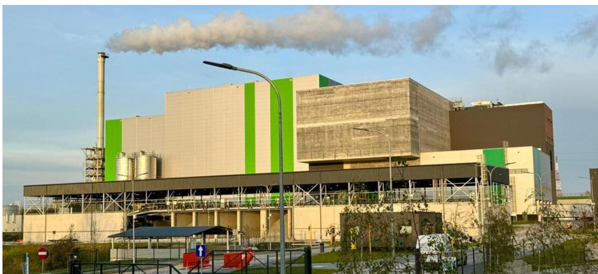
Fot. Instalacja Termicznego Przekształcania Odpadów przy ul. M. Bublewicza 6 w Olsztynie.
