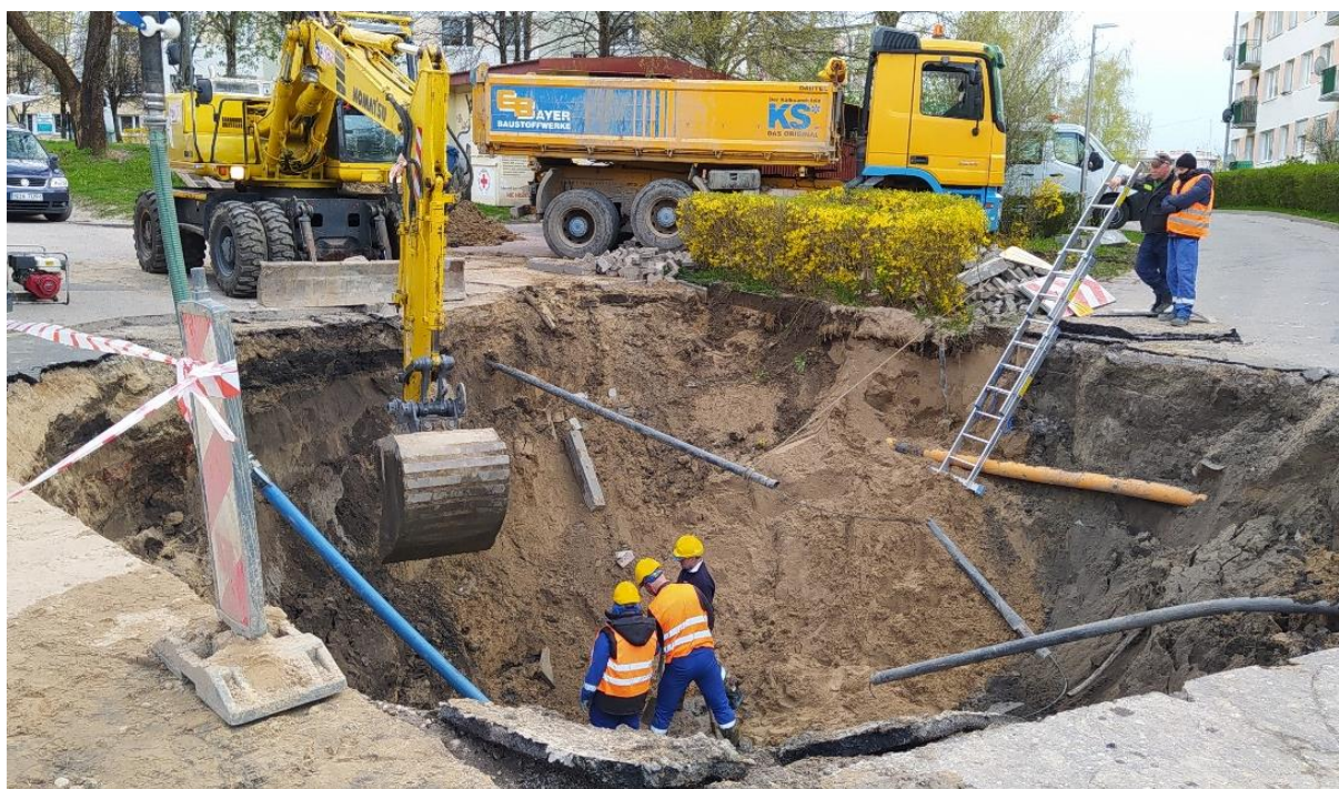
Fot. PWiK Sp. z o.o. Usuwanie awarii sieci wodociągowej przy ul. Polnej
