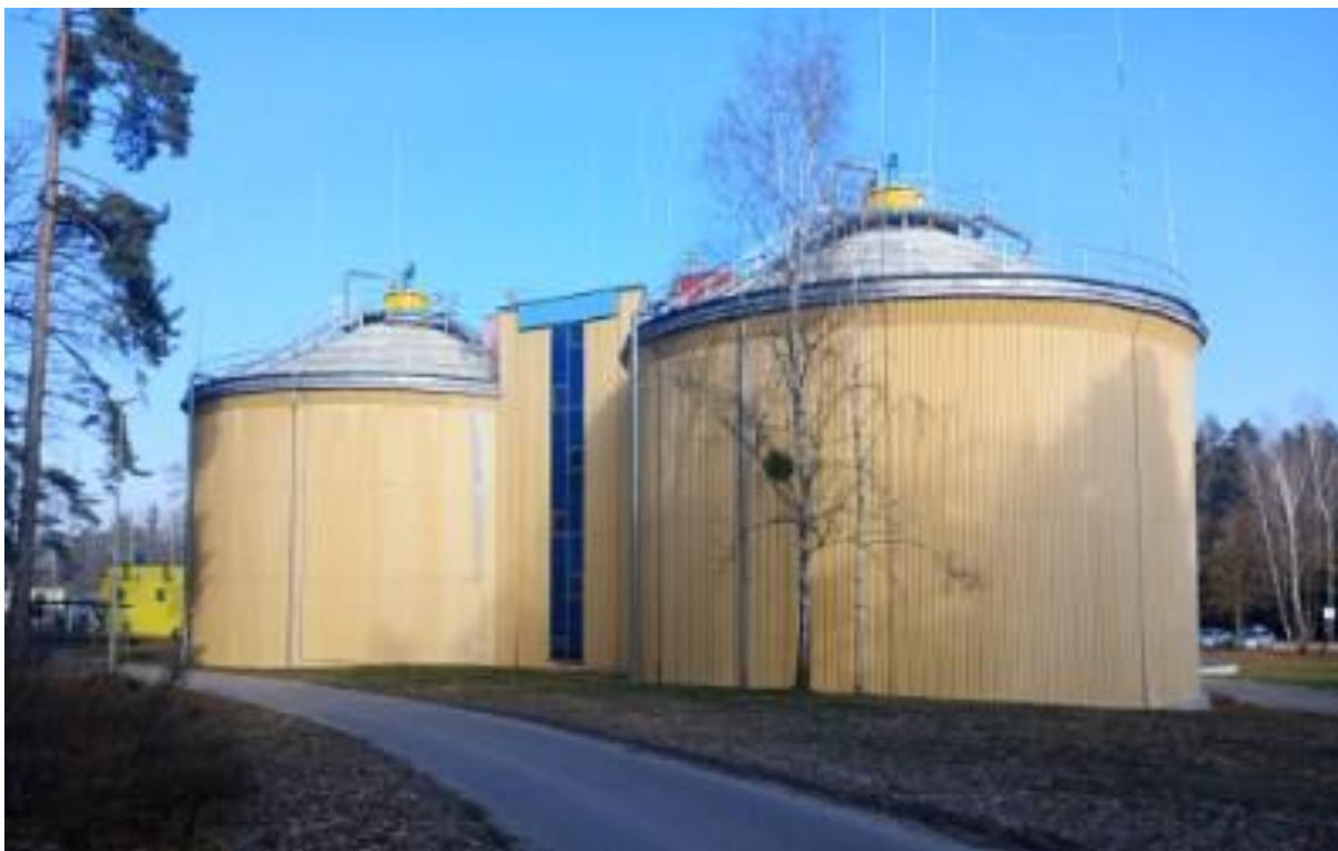
Fot. PWiK Sp. z o.o. Remont kopuł ZKF1 i ZKF2 na terenie Miejskiej Oczyszczalni Ścieków „Łyna”
