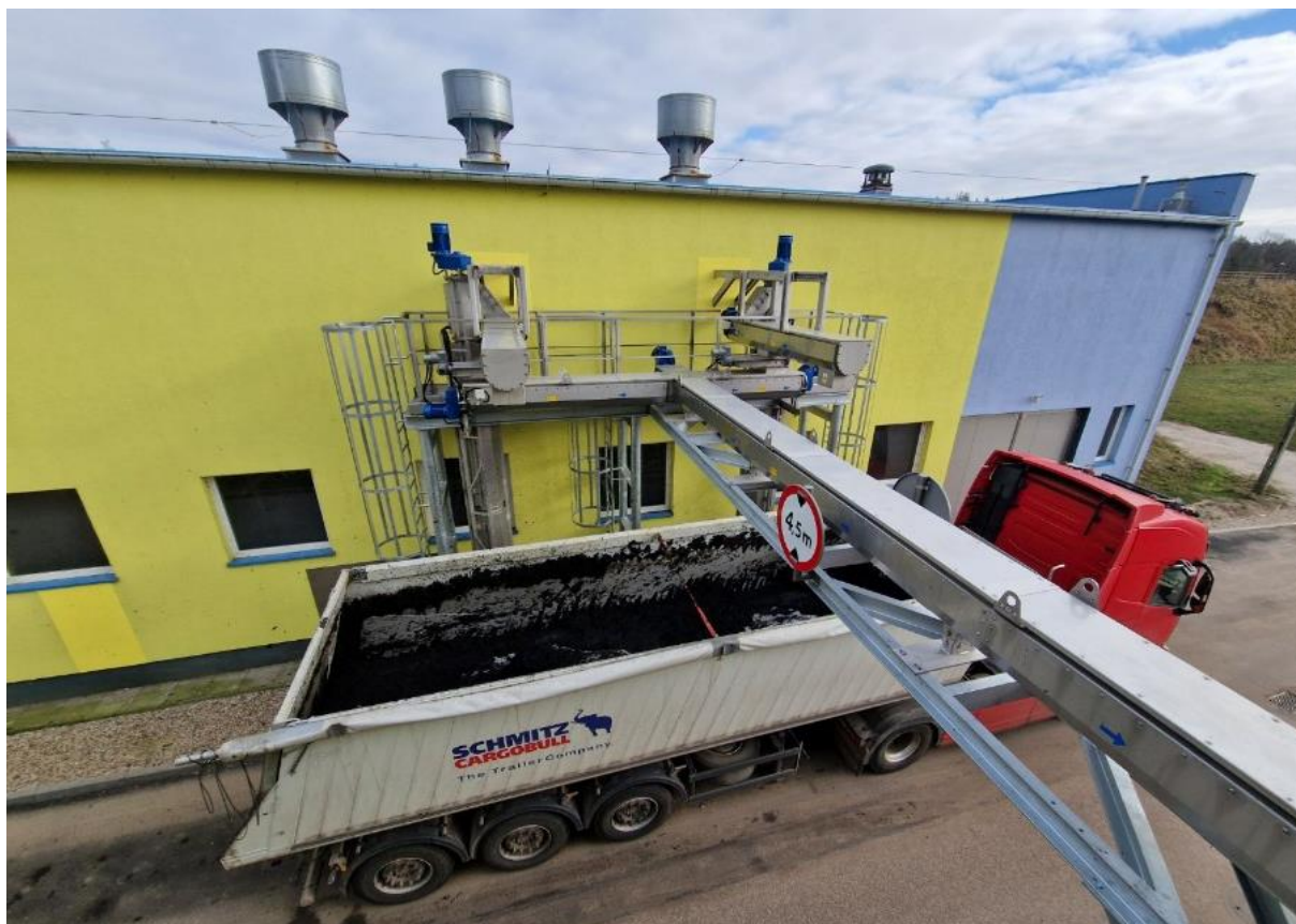
Fot. PWiK Sp. z o.o. Przebudowa przenośników odprowadzających osady z hali pras na kontenery i spalarnię na terenie Miejskiej Oczyszczalni Ścieków „Łyna”
