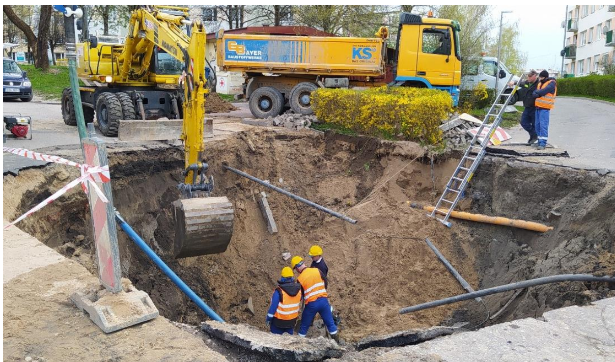
Fot. PWiK Sp. z o.o. Usuwanie awarii sieci wodociagowej przy ul. Polnej
