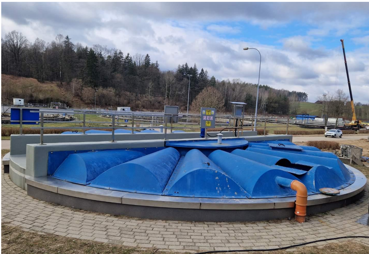
Fot. PWiK Sp. z o.o. Remont zagęszczaczy grawitacyjnych osadu wraz z komorą rozdziu na terenie Miejskiej Oczyszczalni Ścieków „Łyna”
