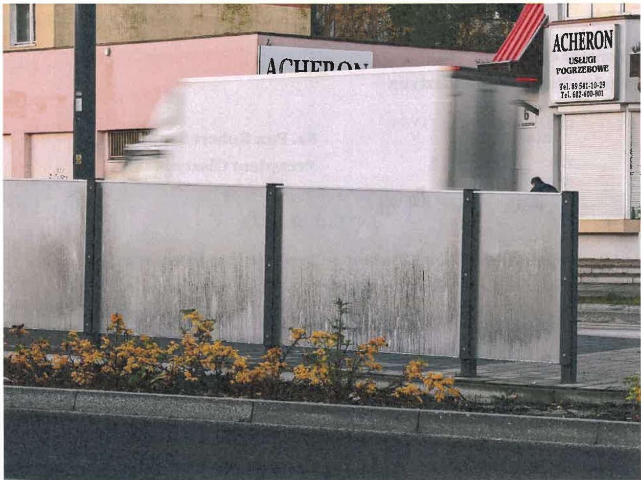
Szklane ogrodzenie przy przystanku komunikacji miejskiej, ul. Krasickiego
